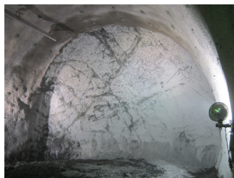
写真-2 球面切羽全景 (C -a(f), L_s=2L )
