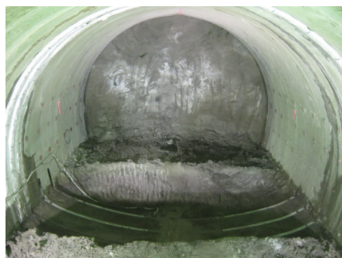
写真-1 早期閉合状況( L_f=9\text{m} , L_c=3\text{m} )
