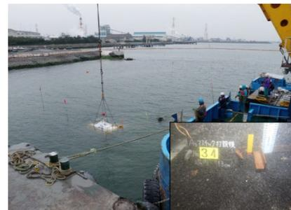
写真-1 ケーソン据付け面
