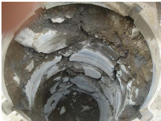
写真 3-2 捨石等障害物切削状況（φ750mm）
