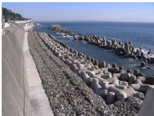
写真 2-1 消波ブロック護岸 施工完了
