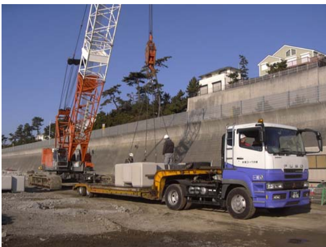
写真 3-15 根固ブロック運搬状況
