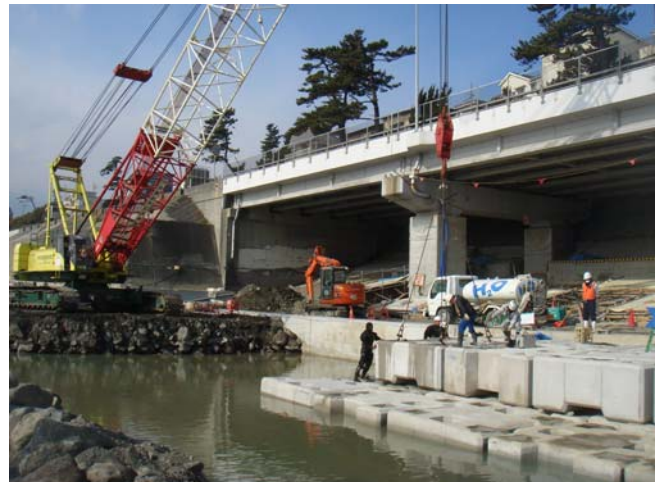
写真 3-16 根固ブロック据付状況
