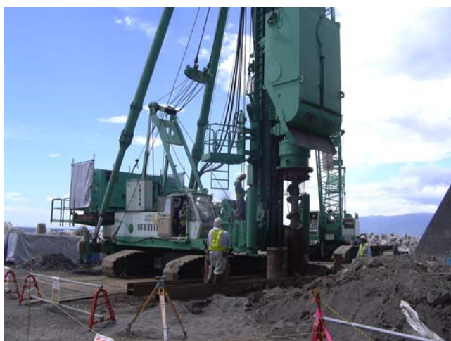
写真 3-3 鋼管矢板中掘り圧入状況
