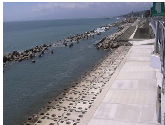
写真 2-2 根固ブロック護岸 施工完了
