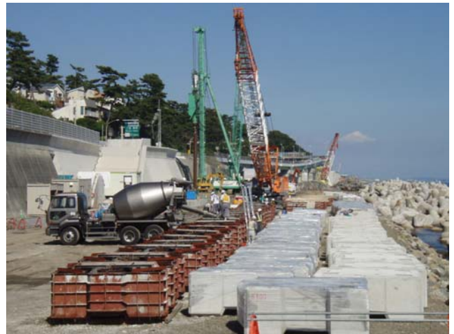
写真 3-14 根固ブロック製作状況
