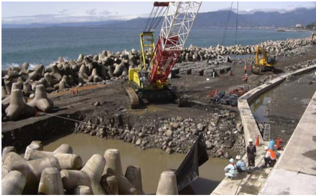
写真 3-7 洗掘防止マット敷設状況 (1)
