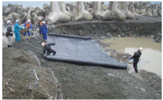
写真 3-8 洗掘防止マット敷設状況 (2)
