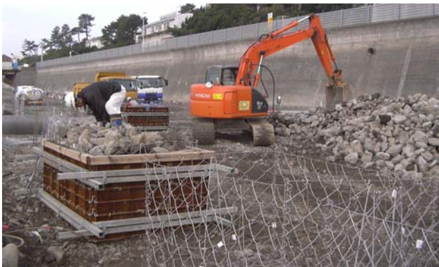
写真 3-9 港湾築堤マット製作状況
