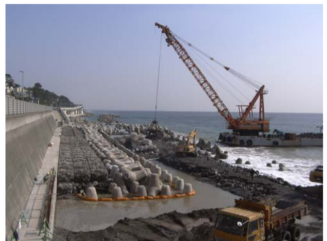
写真 4-1 波除け捨石堤設置状況
