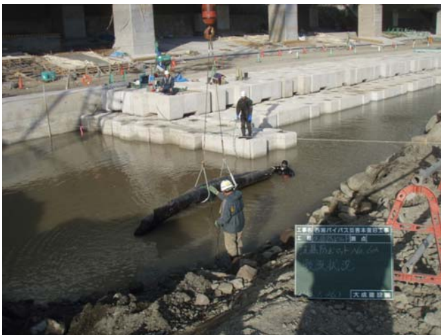
写真 3-13 洗掘防止マット敷設状況
