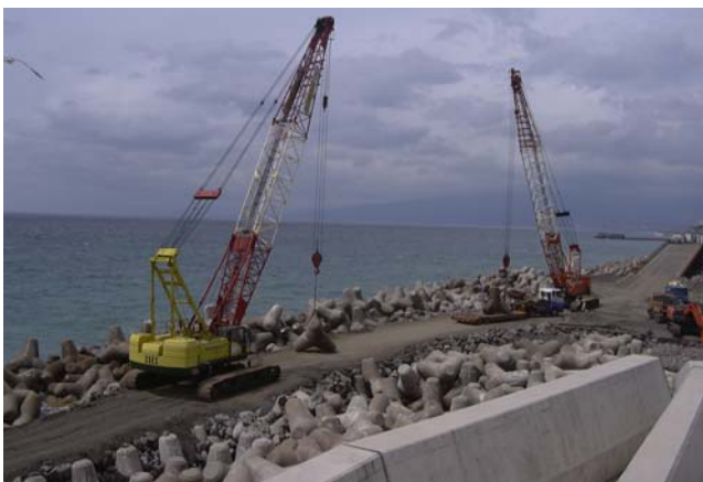
写真 3-11 消波ブロック場内運搬状況
