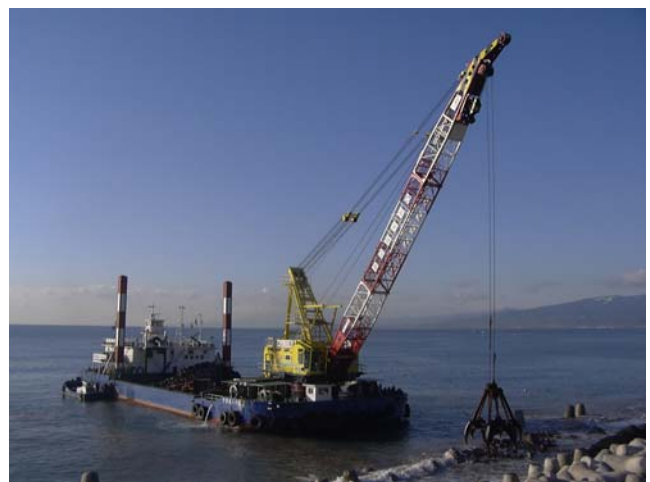
写真 3-6 捨石掘削状況（海上施工）
