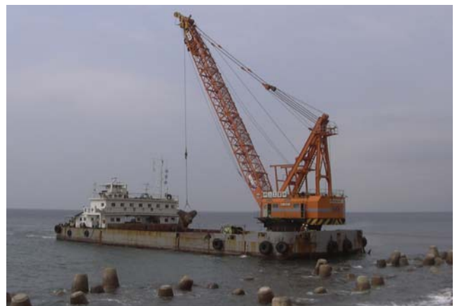
写真 3-12 消波ブロック撤去状況 (海上施工)
