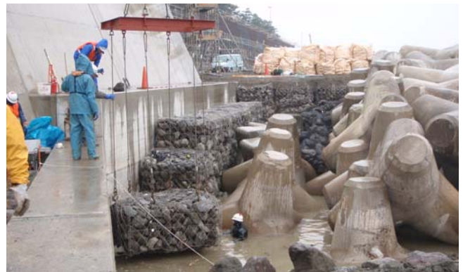
写真 3-10 港湾築堤マット据付状況
