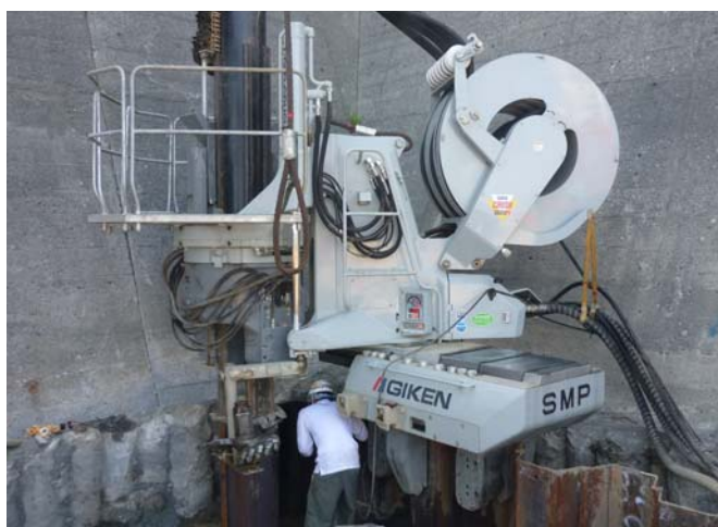
写真 3-4 鋼矢板オーガー併用圧入状況
