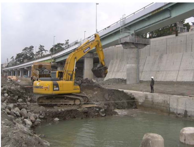
写真 3-5 捨石掘削状況（陸上施工）
