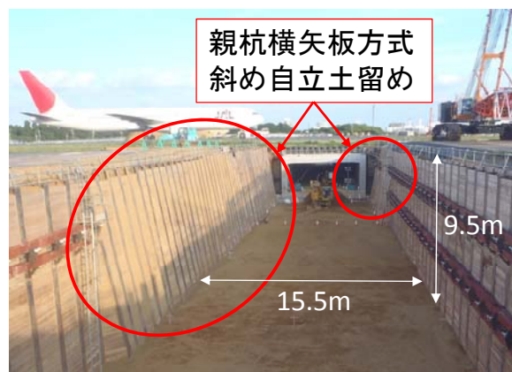
写真-1 親杭横矢板形式斜め自立土留め
