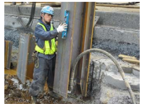
写真-3 傾斜モニター
