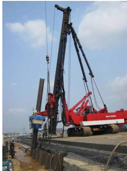
写真-2 中型三点式杭打機+CHV
