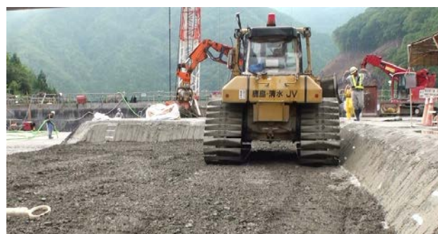
写真－４ １：０．８ 端部法面打継ぎ施工状況（ブル転）
