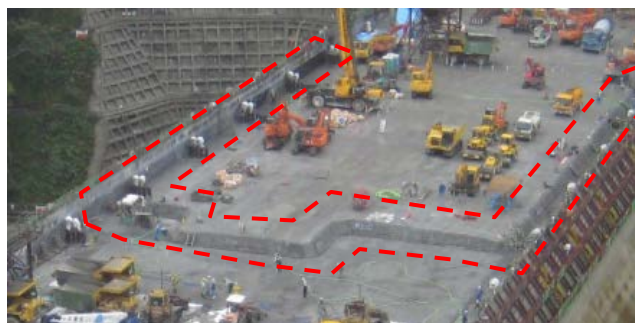
写真－２ １：０．８ 端部法面の打継ぎ全景
