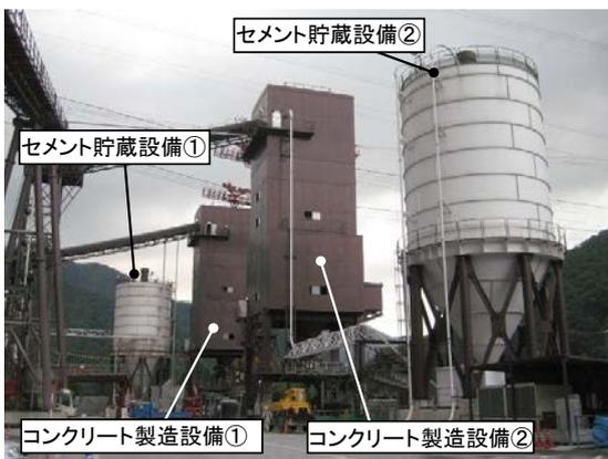
写真-5 コンクリート製造設備
