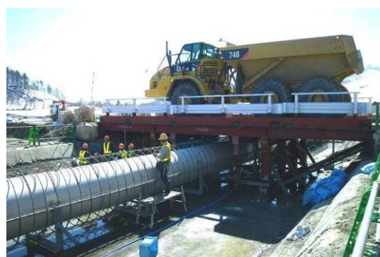
写真-10 25BL 横断栈橋設置
