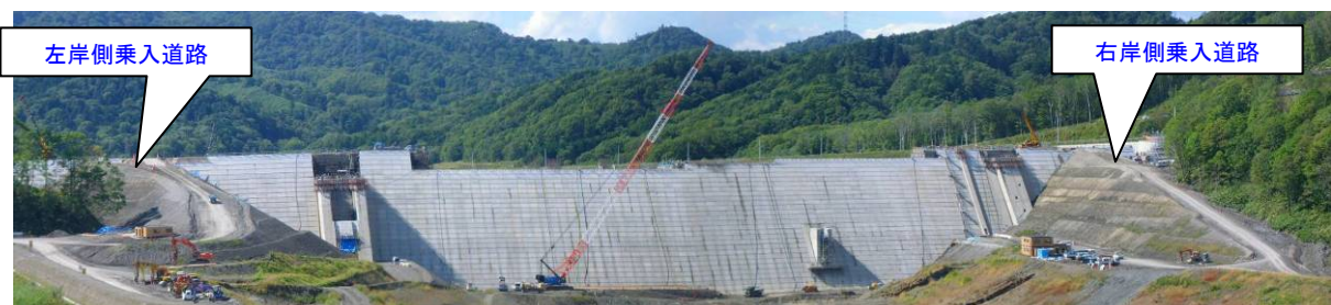
写真-2 左右岸堤体乗入道路
