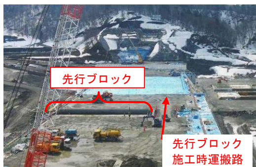
写真-7 上流側堤内仮排水路先行設置
