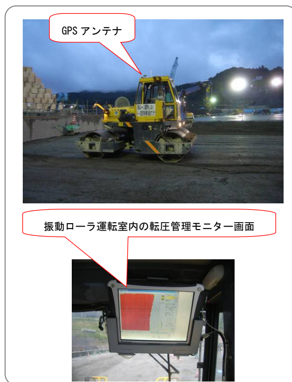
写真-12 GPS 装置による転圧回数管理システムを搭載した振動ローラ
