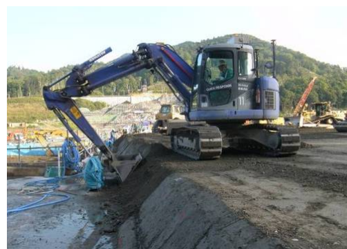
写真-4 CSG 法肩部の整形状況
