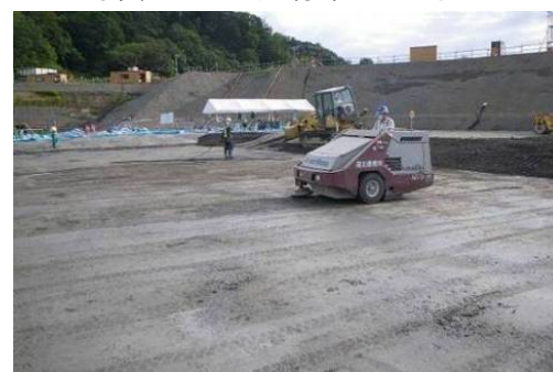
写真-5 清掃車による CSG 打継面の清掃
