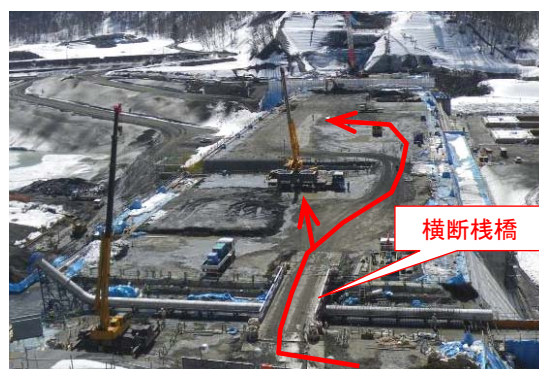
写真-9 25BL 横断栈橋設置
