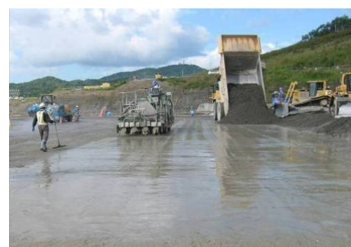
写真-6 セメントペースト散布状況
