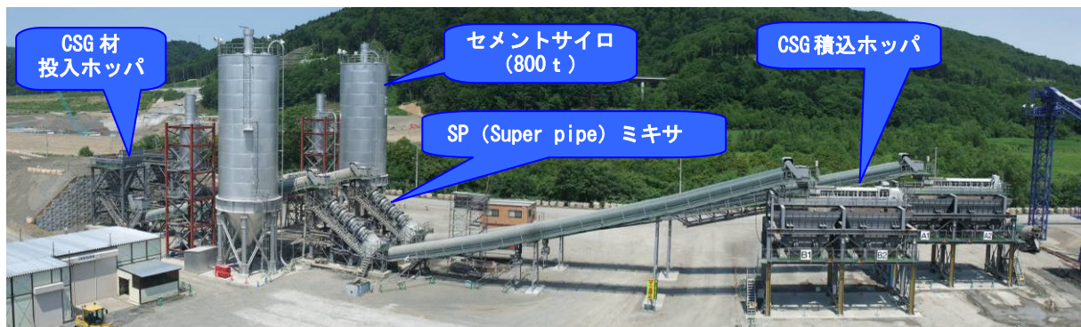
写真-1 製造設備全景
