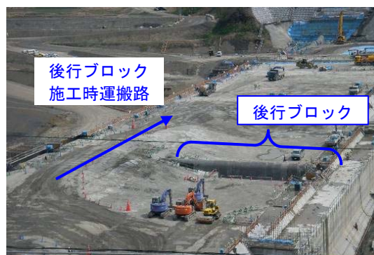
写真-8 下流側堤内仮排水路設置
