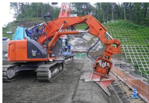
写真-3 CSG 法肩部の締固め状況
