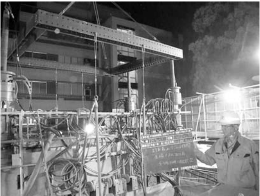
写真-4 ウォータージェット施工状況
