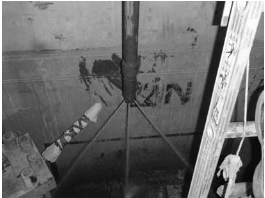
写真-5 ウォータージェットの先端ノズル（3方向噴射型）
