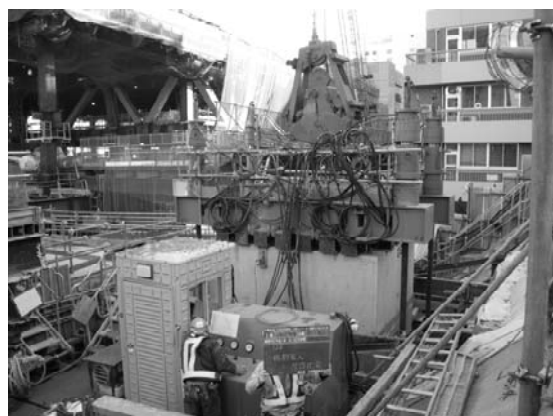
写真-1 掘削圧入状況
