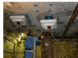
写真-4 新設アンカーボルト設置
