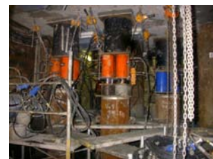
写真-5 鋼管杭圧入
