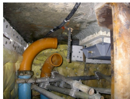
写真-7 コンクリート打込み配管
