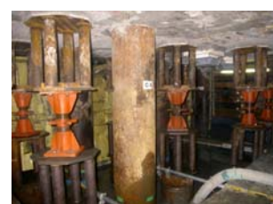
写真-6 プレロード導入完了
