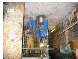
写真-3 既設アンカーボルト撤去
