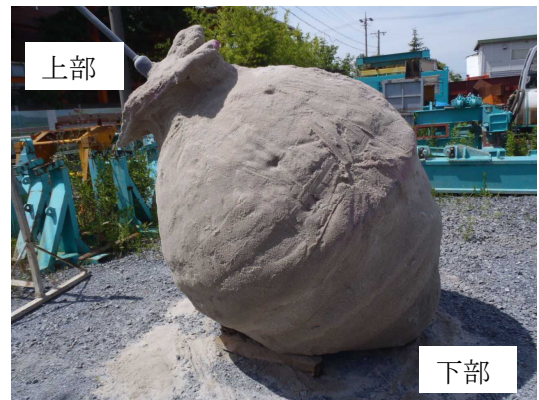
写真—3 改良体全景
