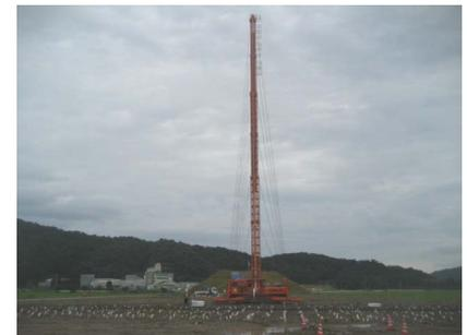
また、この推定式から算出した地盤強度と打設位置情報を用いて、PBD打設地盤内の地質分布図を作成し、実現場における事前調査結果や動態観測結果と比較することで、その適用性・有用性についての検討を行った<sup>2)</sup>。
