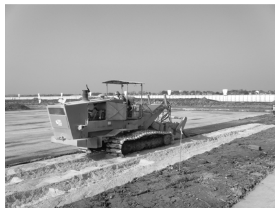
写真-2 表層改良施工状況
