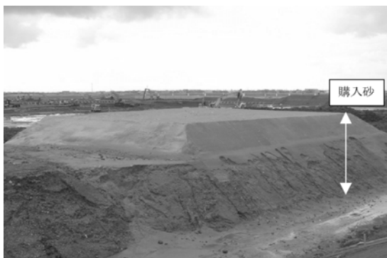
写真-3 試験盛土状況（盛土完了時点）
