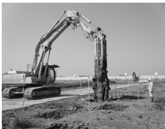
写真-1 杭式改良施工状況
