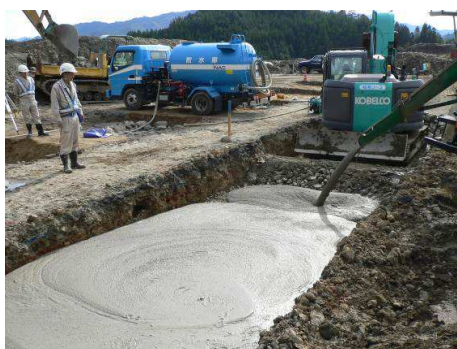
写真-4 モルタル投入状況(ケース 3)
