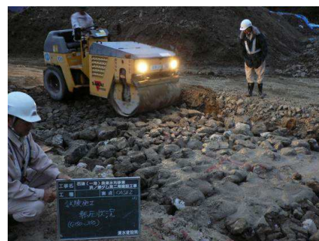
写真-5 転圧状況(ケース 3)
