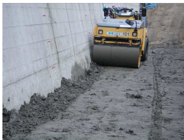
(b) 転圧状況
