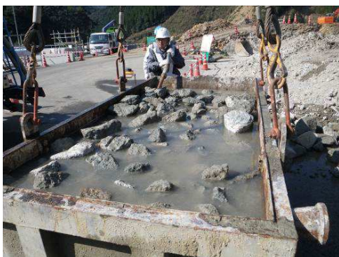
写真-3 空隙率試験状況
