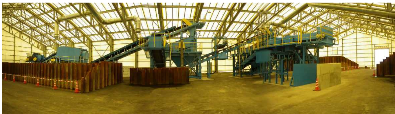
写真-5 作業ヤード全景
