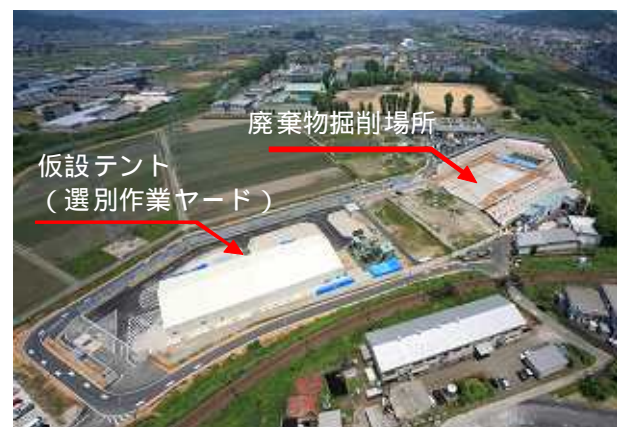
写真-1 廃棄物修理対策現場全景
