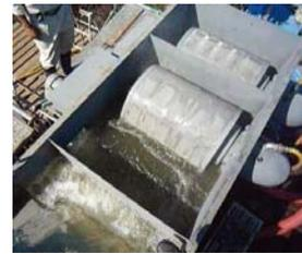
写真-5 分離槽への金網設置状況
