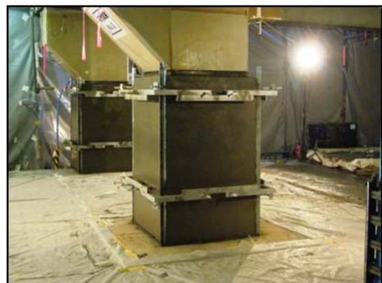
写真-4 試験施工完了
