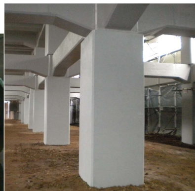
写真-11 施工完了
