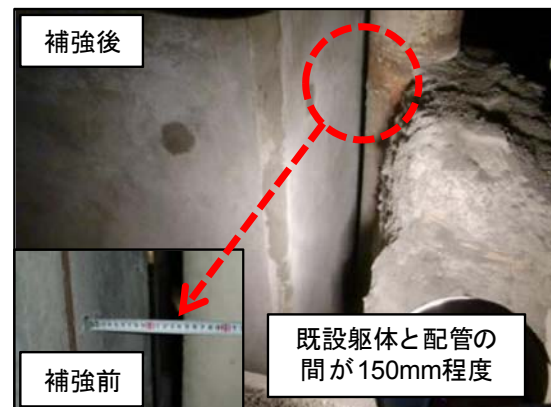
写真-2 狭隘部施工前後の状況
