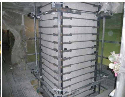
写真-9 吹付け定規の設置状況
