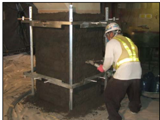
写真-3 試験施工状況（吹付けモルタル）
