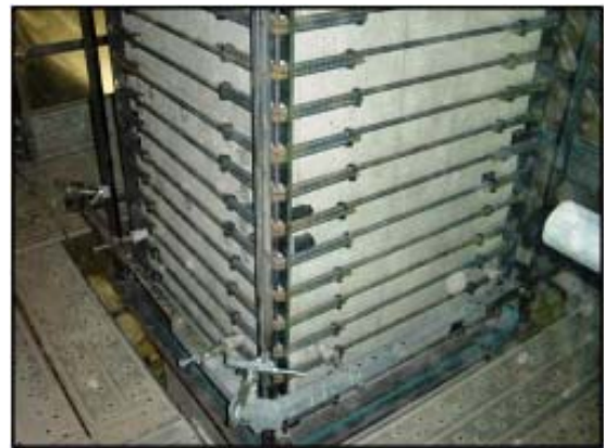
写真-1 鉄筋組立完了
