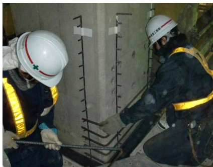
写真-8 鋼材の組立状況
