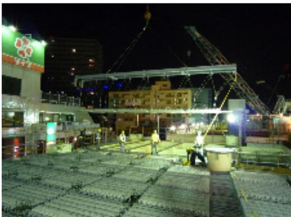
写真-2 専用吊具を利用したHPCa床版設置状況
