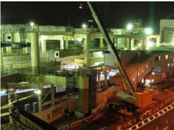
写真-6 GA0桁(2F)架設状況
