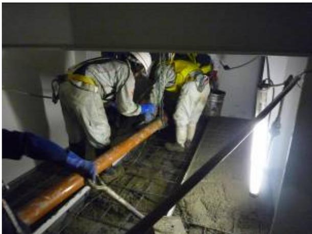
写真-10 制振コンクリート打設状況
