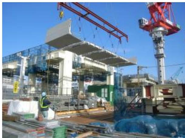
写真-4 合成桁HPCa床版設置状況
