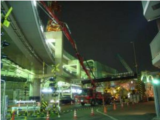
写真-9 床版コンクリート打設状況
