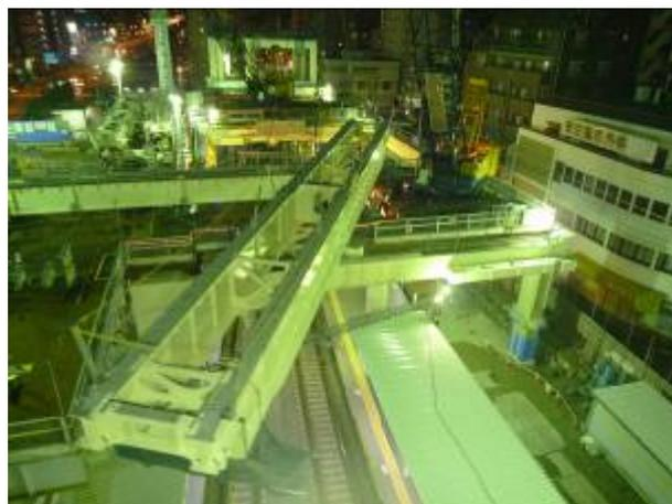
写真-3 G63 2F 本線側合成桁架設状況
