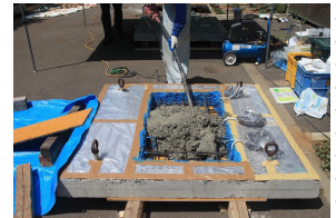
写真-13 超速硬 Co 打込み
