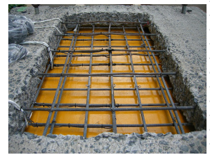
写真-11 床版底面型枠設置
