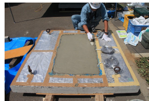
写真-14 打替部表面仕上げ
