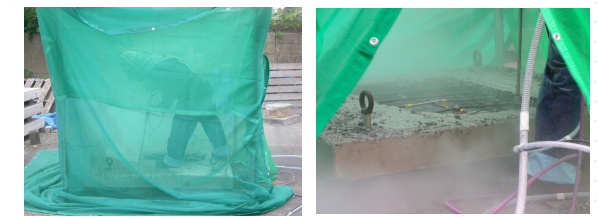
写真-8 WJ 打抜き（状況） 写真-9 WJ 打抜き（完了）
