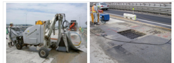
写真-6 WJ 打抜き（状況） 写真-7 WJ 打抜き（完了）
