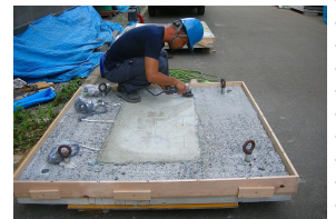
写真-15 打替部ケレン
