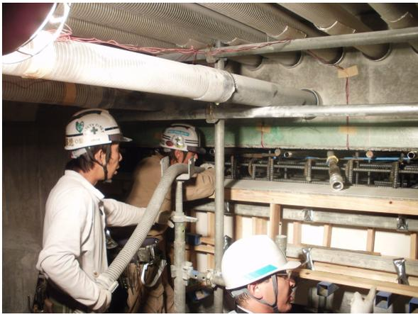
写真 - 6 箱桁内での打設状況（下層）
