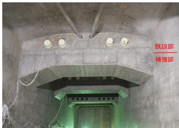
写真 - 8 補強後の定着突起
