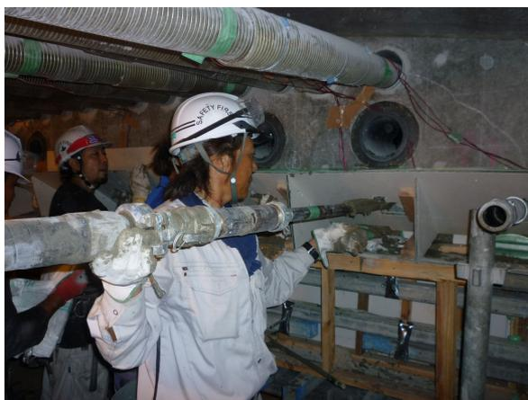
写真 - 7 箱桁内での打設状況（上層）
