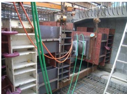
写真-2 水平変位導入設備
