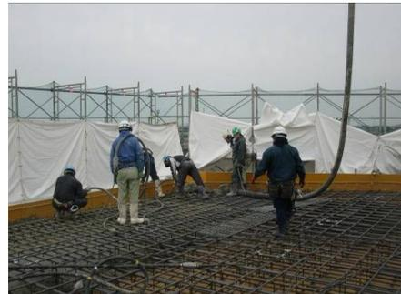
写真-6 コンクリート打設状況
