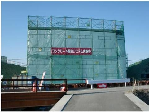
写真-2 養生設備外観
