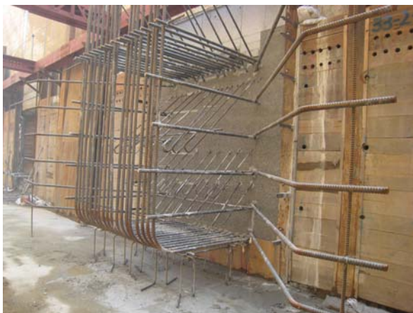
写真-8 下床桁（打設完了後）
