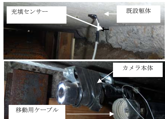
写真-5 充填センサーおよび CCD カメラ設置写真
