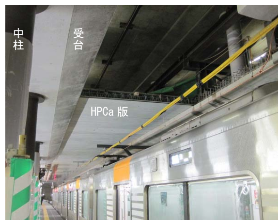
写真-3 HPCa版の施工状況
