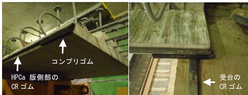
写真-4 漏水防止ゴムの設置状況
