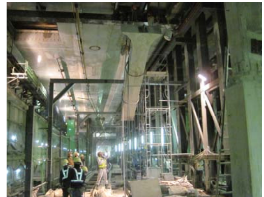
写真-2 既設構造物撤去状況（ロート部）
