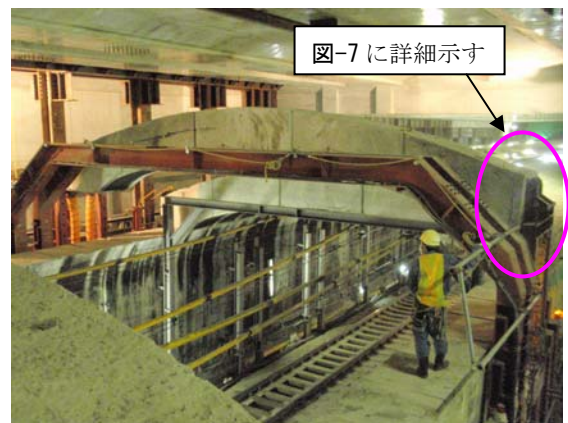
写真-1 アーチ部の撤去状況
