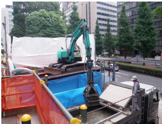
図 13 発進立坑汚泥搬出状況
