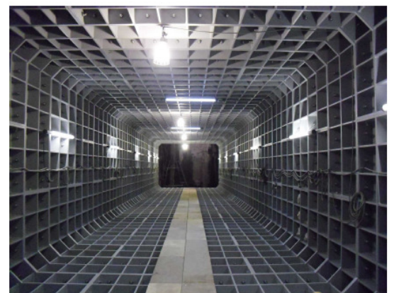
図 15 トンネル内一次覆工完了状況
