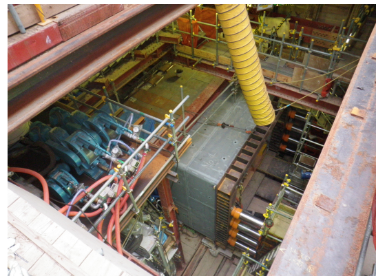
図 14 発進立坑内設備配置状況
