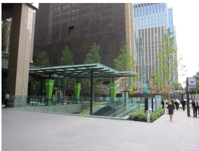
図-7 地上部状況
