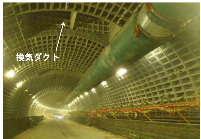
写真-8 本線接続状況
