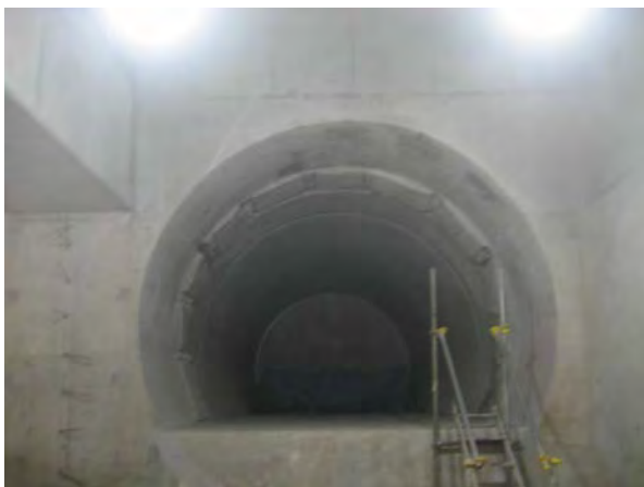
写真-7 覆工完了状況
