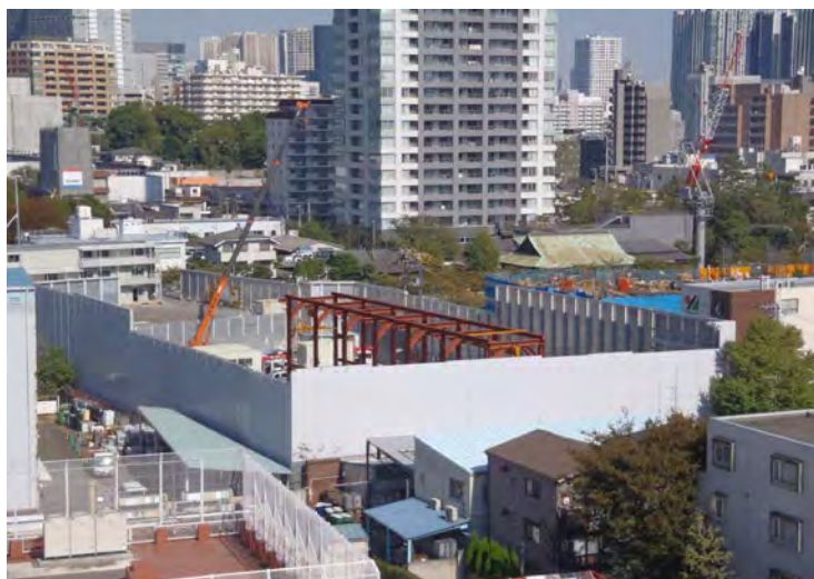
写真-1 工事箇所周辺環境
