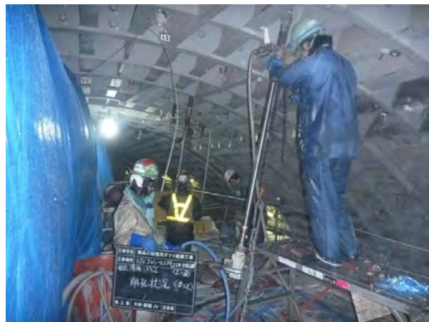
写真-4 薬液注入施工状況-2 (シールド内 低圧浸透注入工法)
