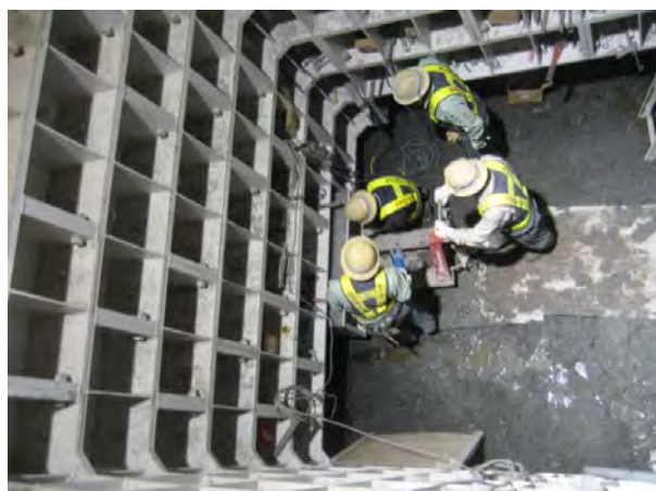
写真-6 鉛直ダクト施工状況
