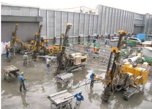
写真-3 薬液注入施工状況-1 (路上ダブルパッカ工法)
