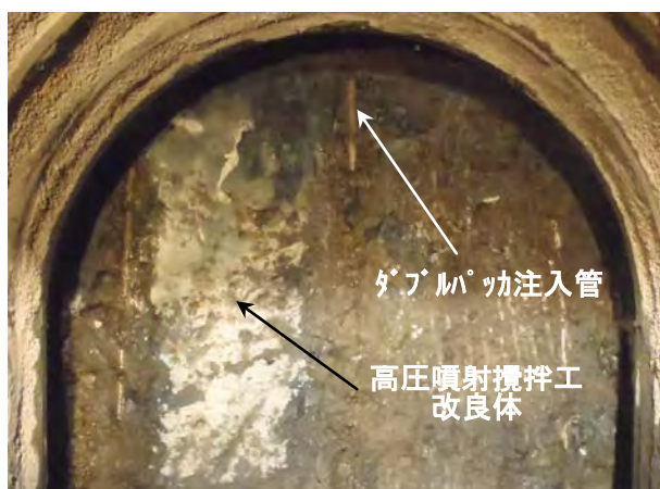
写真-5 トンネル切羽状況
