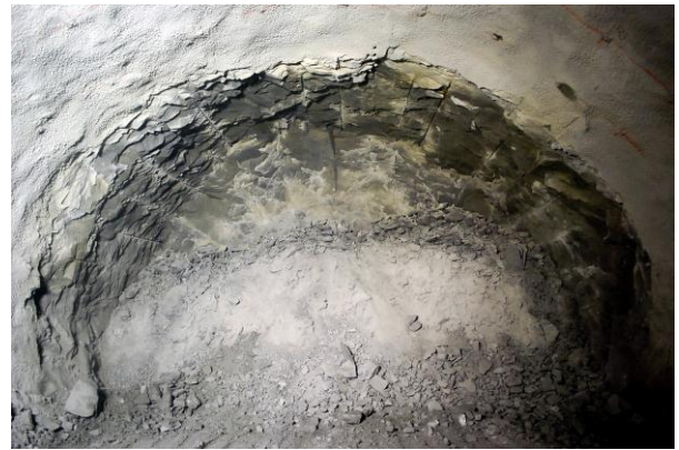
図-10 トンネル壁面状態
