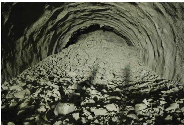
図-9 発破直後の状況
