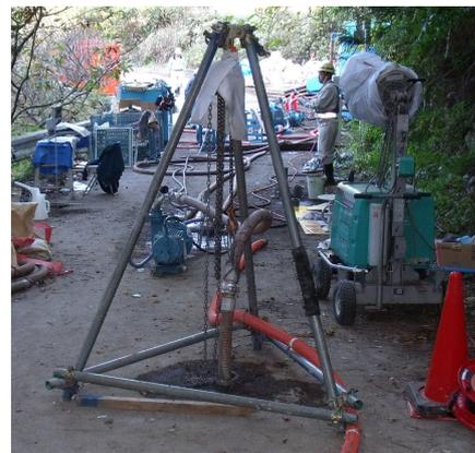
写真-7 実施工における端部隔壁打設孔
