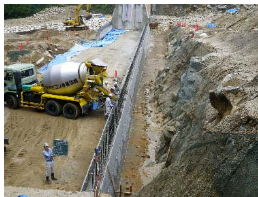
写真-5 Wメル施工状況
