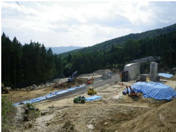
写真-3 施工箇所全景
