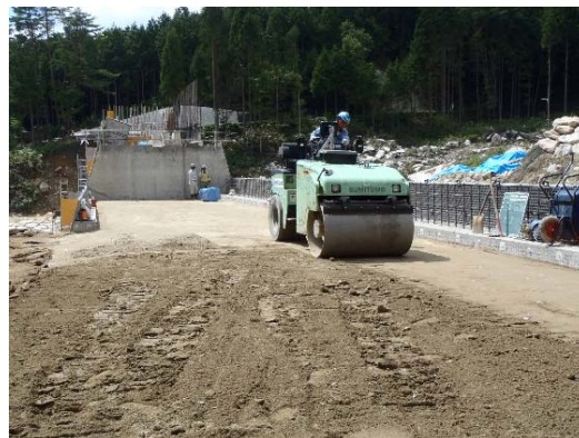
写真-6 INSEM 転圧状況
