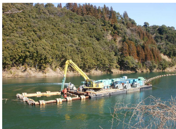
写真-4 浚渫台船
