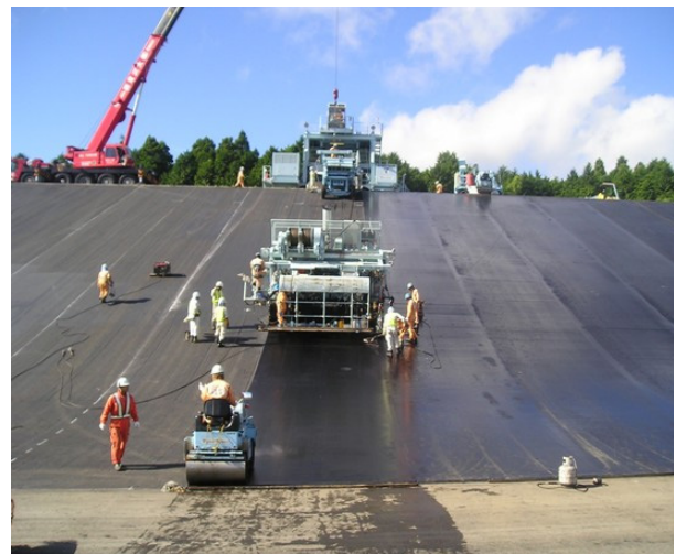
写真-1 舗設状況
