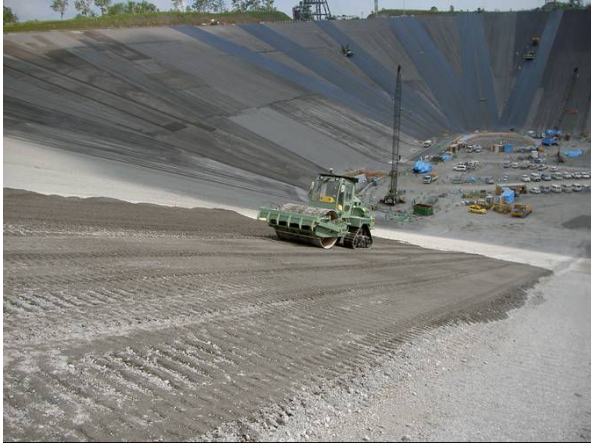
写真-5 転圧状況
