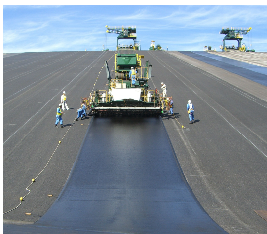
写真-2 施工状況
