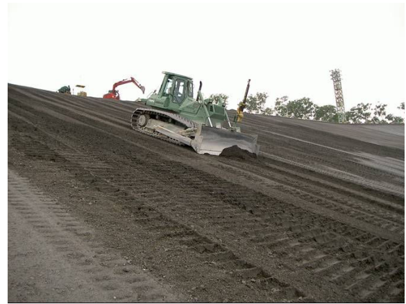
写真-6 3D-MCブルドーザによる敷均し
