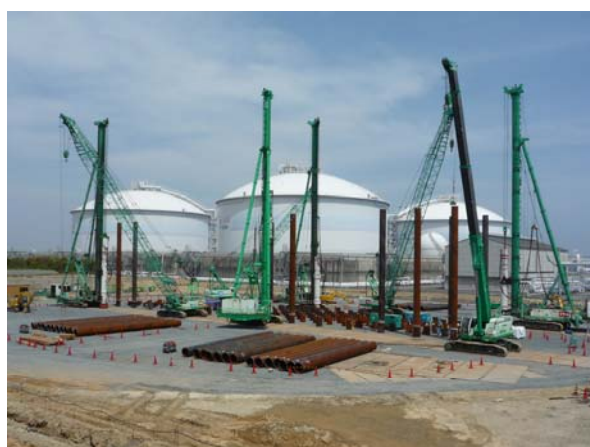
図-9 基礎杭打設状況
