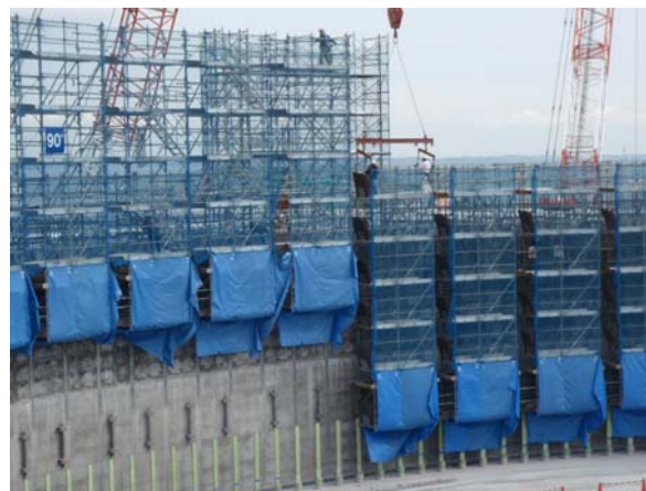
図-14 足場スライド状況
