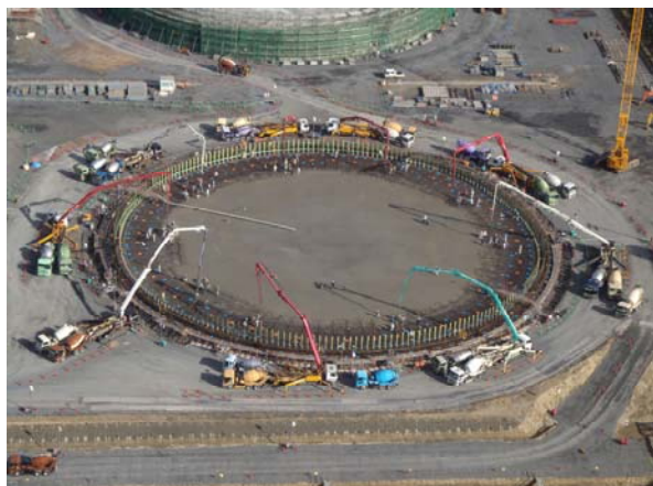
図-11 基礎版コンクリート打設状況
