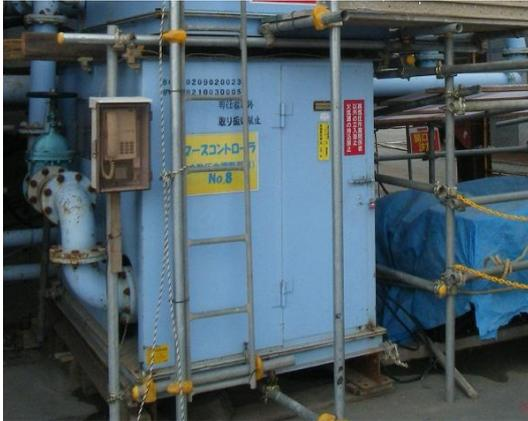
写真-5 電気式自動圧力調整装置
