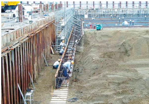
写真-2 刃口金物設置状況
