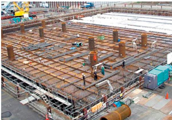
写真-3 スラブ鋼板設置状況
