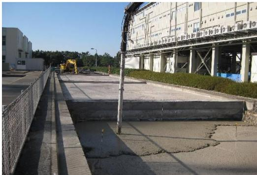
写真-7 流動化処理土の打設状況
