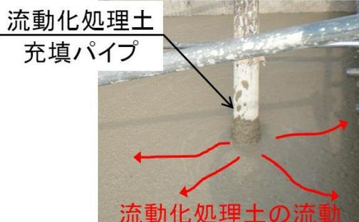
写真-8 流動化処理土の流動状況
