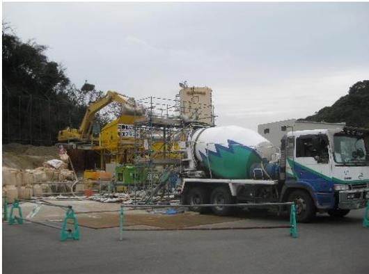
写真-6 トラックミキサー車への投入状況
