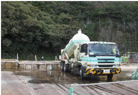
写真-2 貯泥ピットへの投入状況
