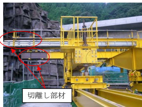
写真-4 作業移動車と切離し部材
