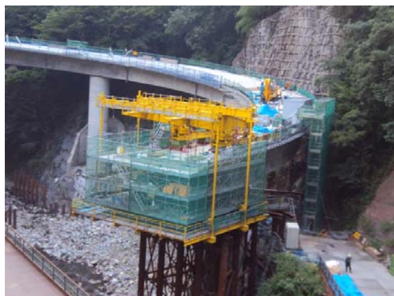
写真-1 張出し架設状況
