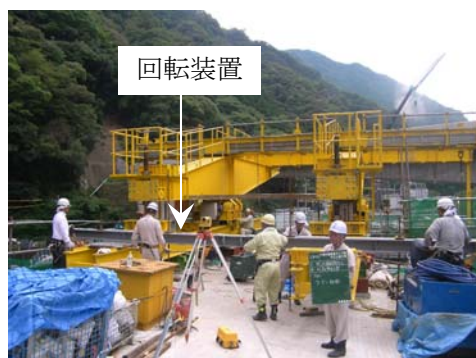
写真-2 回転装置付レールアンカー
