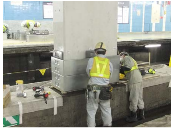
写真-1 施工状況
