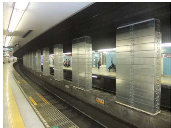
写真-2 工事完了状況
