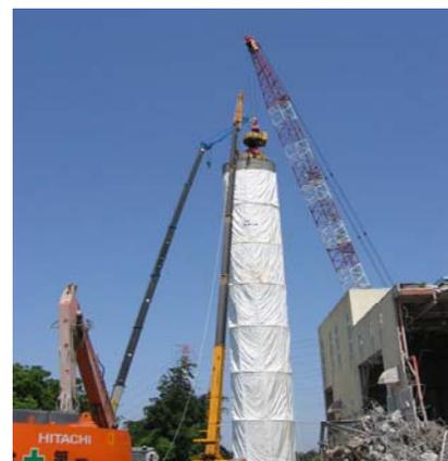
写真-6 飛散抑制シート
