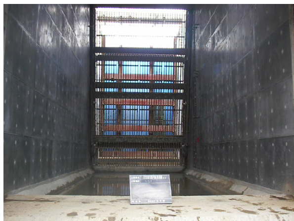
写真-14 高耐久埋設型枠設置完了全景
