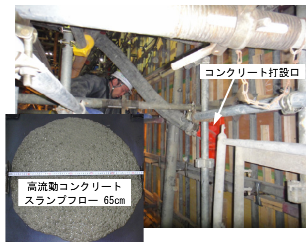
写真-16 高流動コンクリート打設状況 (隔壁第1リフト)
