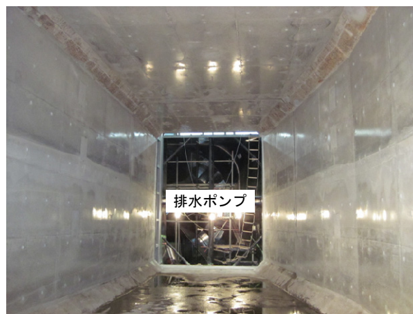
写真-17 断面修復完了全景 (下流吐出部, 3リフト打設)
