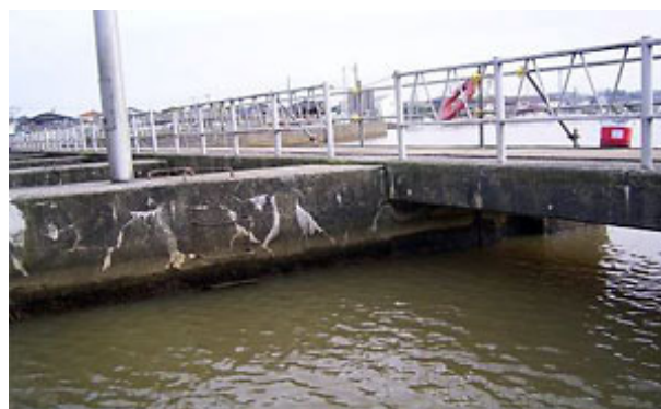
写真-2 躯体コンクリートの現況
