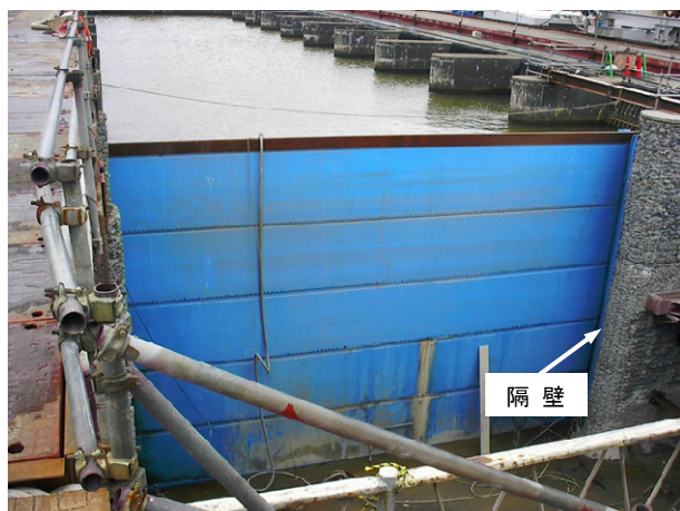
写真-3 仮締切り設置状況(上下流中央部)
