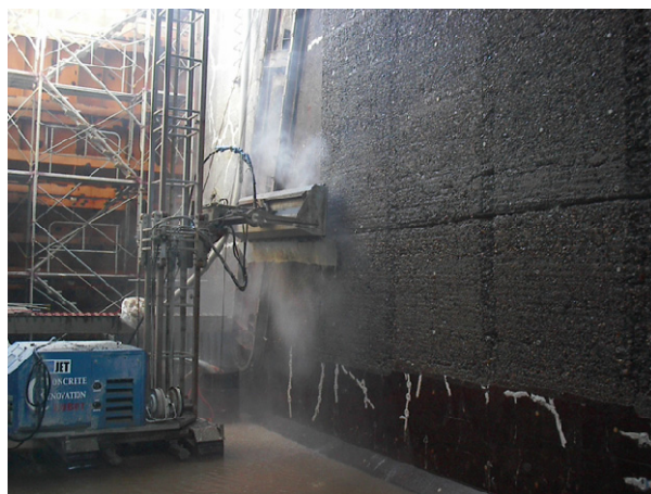
写真-10 機械式ウォータージェット工法による研り状況
