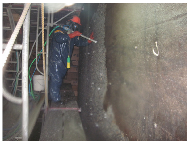
写真-11 人力式ウォータージェット工法による研り状況
