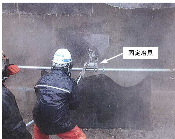
写真-12 固定治具付きガンによる研り状況
