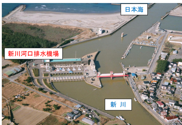
写真-1 新川河口排水機場全景
