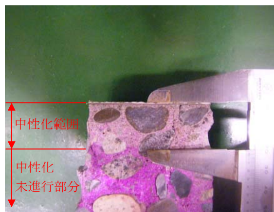
写真-5 中性化深さ測定状況
