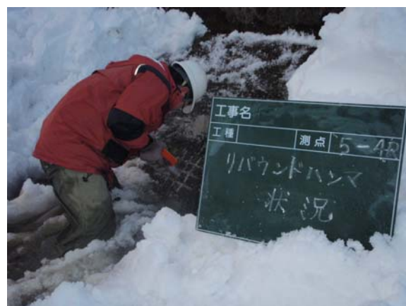
写真-3 反発度法計測状況
