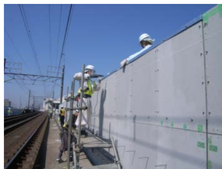
写真-2 施工状況
