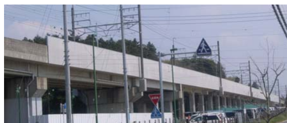
写真-3 外観 (左端は嵩上げ前)
