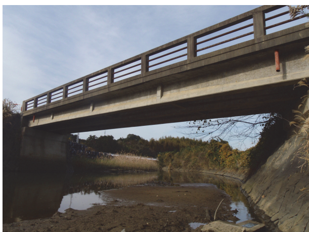
写真-4 実験に使用した橋梁
