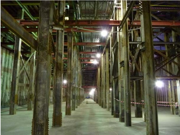
写真-5 掘削完了状況
