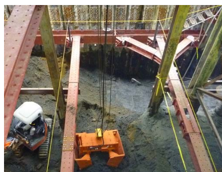
写真-4 掘削状況（3次掘削）
