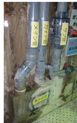
写真-2 土留め壁に設置した集水装置
