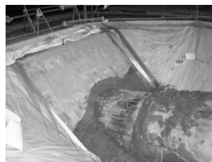
③ シールド通過により発生したテールボイドに裏込め材を充填し、坑口を仕上げる。
