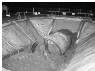
② 地表面・法面を監視しながら掘進を継続する。
