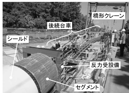
写真-2 発進時シールド後方設備
