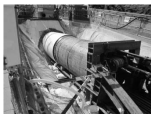
② 法面・地表面を監視しながら仮セグメントを順次組立て掘進を継続する。
