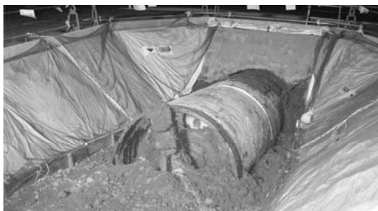
写真-4 シールド地上到達状況
