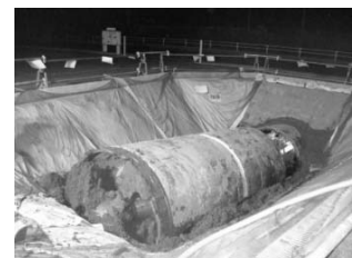
④ シールド解体位置まで掘進（空押し）して完了する。
