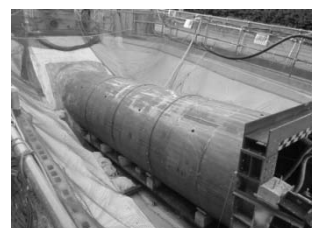
④ テールボイドを裏込め材で充填し坑口を仕上げる。
