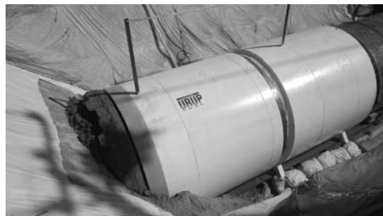
写真-3 シールド地上発進状況
