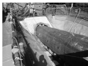
③ 土被り増加に伴い推力が上昇するため、仮セグメントの浮上がり防止しながら掘進を継続する。
