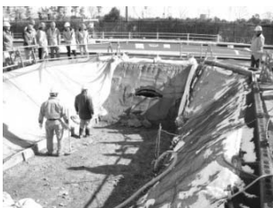
① シールド上部が法面に到達する。
