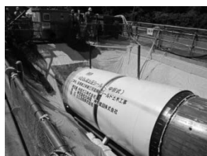
① 法面掘削時に添加材の注入状況・土砂の塑性流動状態を目視で確認しながら掘進する。
