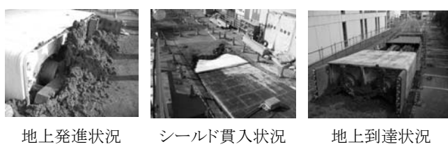
写真-1 URUP実証実験施工状況
