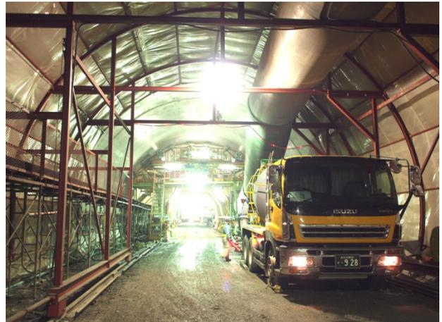
写真-7 3スパン連続覆工コンクリート養生台車
