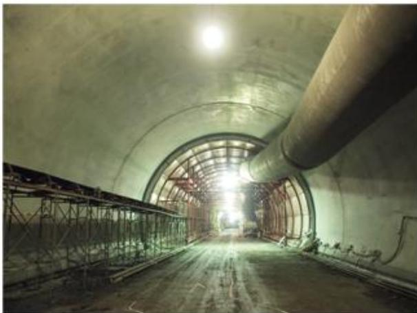
写真-8 中流動覆工コンクリート仕上がり状況
