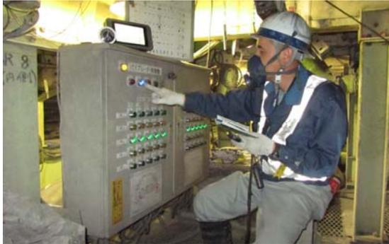
写真-5 型枠パイブレータの集中制御盤
