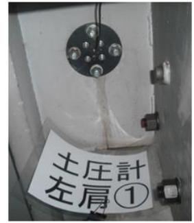
写真-6 打設圧管理用に型枠に設置した圧力計
