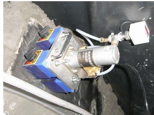
写真-1 改良型貫入装置セット状況
