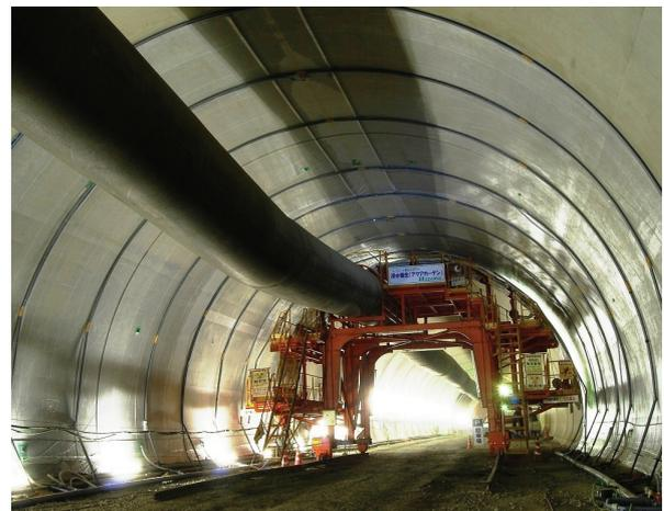
写真-2 浸水養生シート展張完了状況
