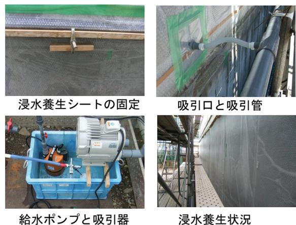
写真-1 浸水養生システムの構成
