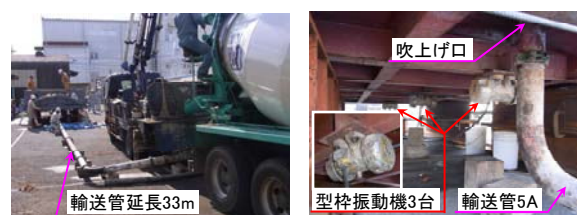
写真-4 コンクリート打設状況
