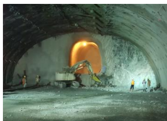
写真-1 アーチ切上げ完了時
