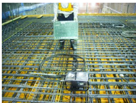
写真-9 打設前の小型（φ=28mm）パイブレータ
