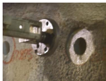
写真-4 支圧面整形用ビット
