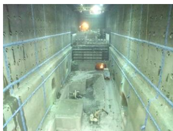
写真-2 ベンチ部掘削終了時
