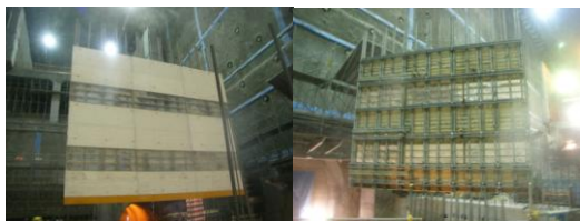
写真-8 大型樹脂型枠（左がコンクリート側）
