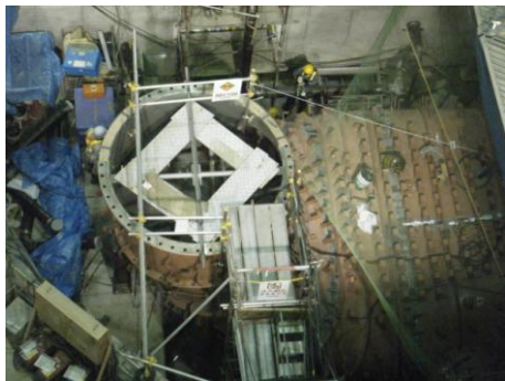
写真-12 ドラフトチューブの設置状況
